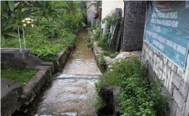
Gambar 11. Saluran irigasi yang menjadi satu dengan drainase
